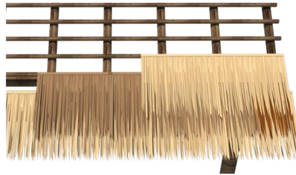
3ra Fila de Palma instalada [Comienza con una hoja completa]
